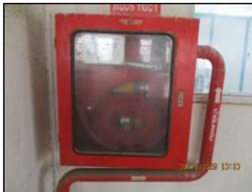
ภาพที่ 2.15 ระบบดับเพลิงภายในโครงการ
